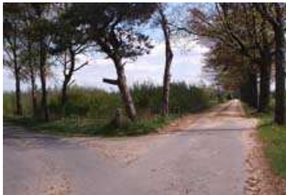
Rechts is de Nijmansedijk.
